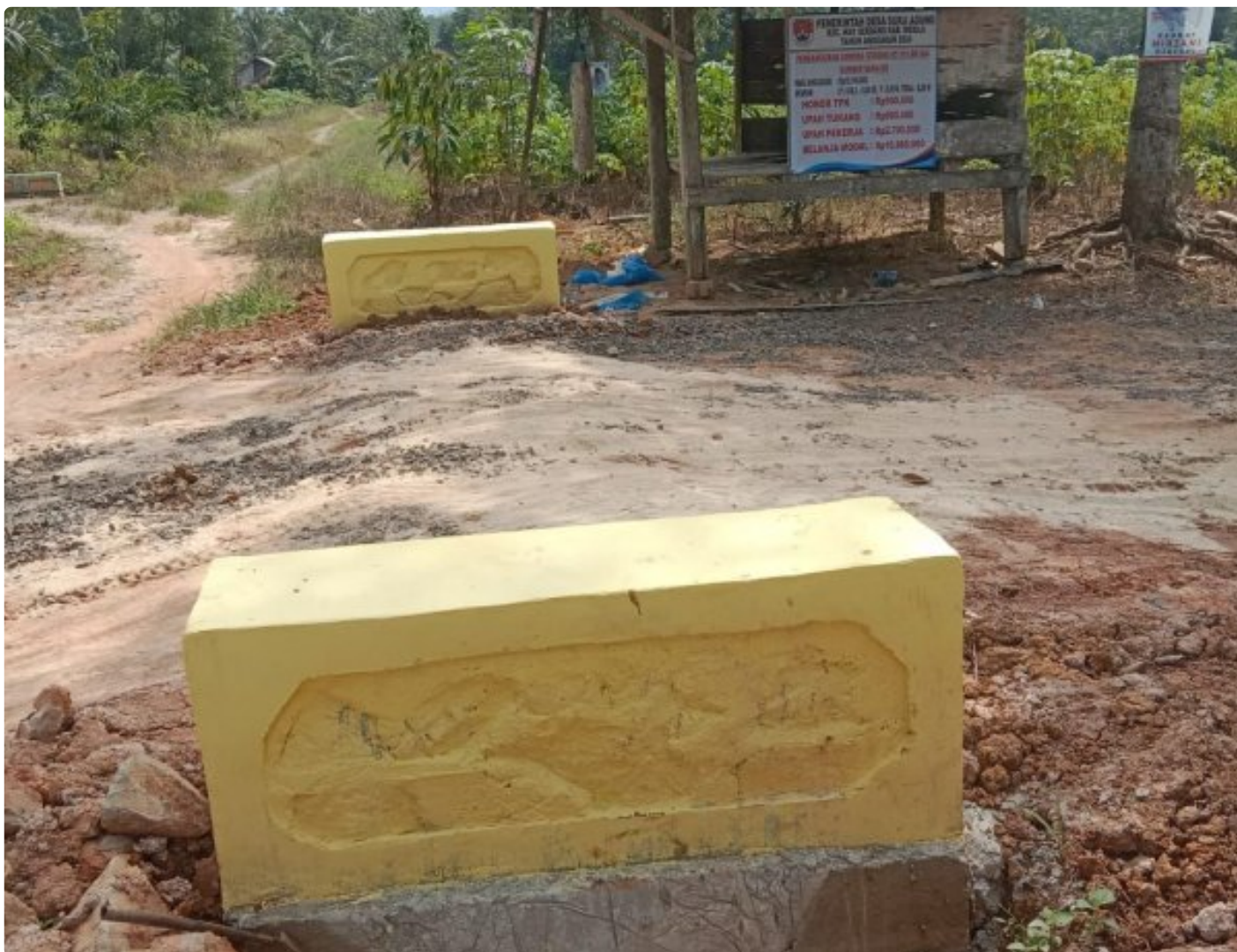
Pembangunan gorong-gorong Desa Suka Agung
