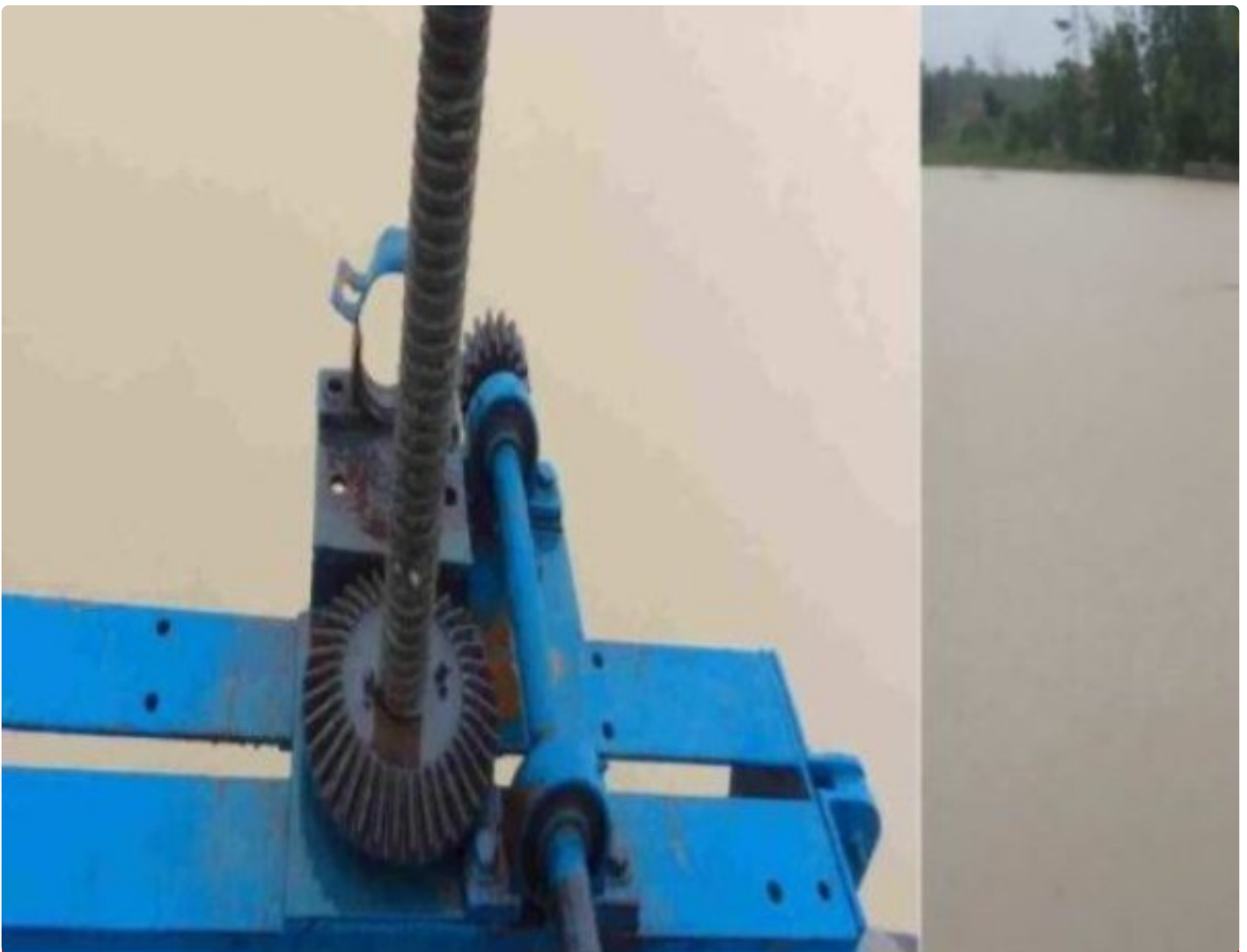
Pintu air Albaret Simpang Mesuji
